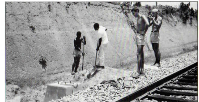
Kabelgrävning i bushen.
